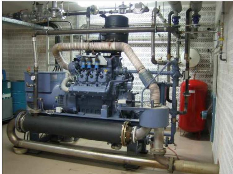
**Photo 6:** Moteur de cogénération biogaz
